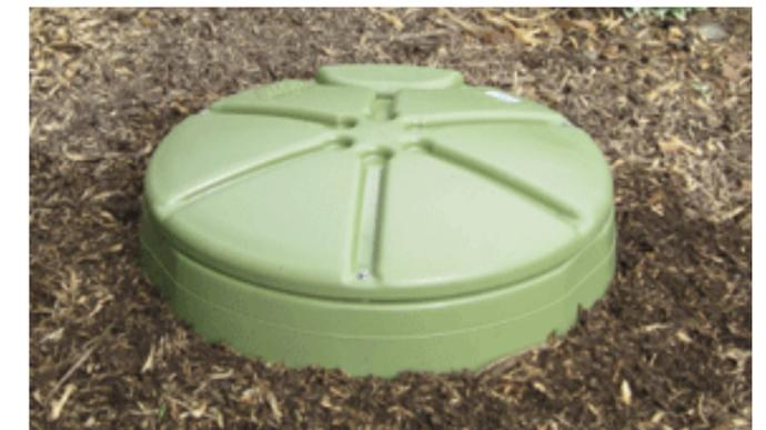
Vista de la Superficie de la Bomba Trituradora (después de la instalación)
