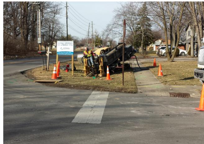
Arriba: Las máquinas perforadoras direccionales permiten que las tuberías se instalen debajo de las calles sin cortes y excavaciones molestas que interrumpen la circulación.
