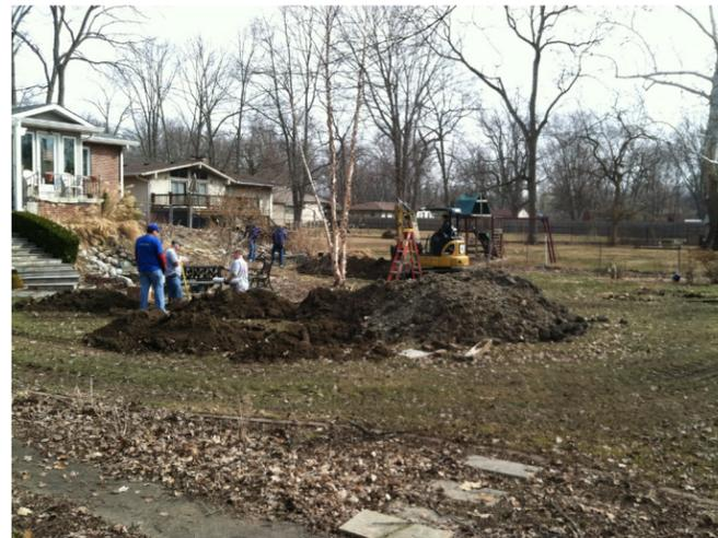
Arriba: Bomba trituradora en curso de instalación. Esta vista muestra la excavación requerida para una instalación típica.
