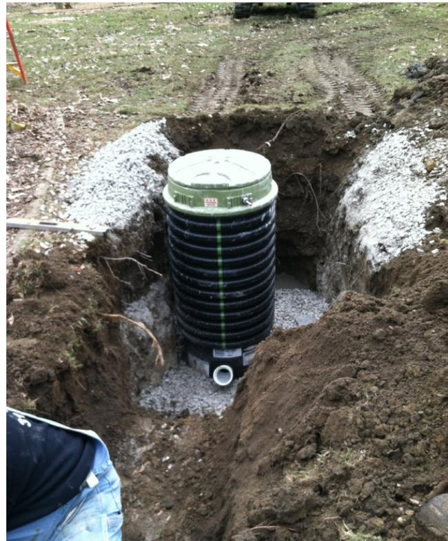
Arriba: A continuación se muestra una vista de la bomba trituradora en la zanja. Esto es antes de colocar las tuberías, rellenar la zanja con tierra y nivelar el sitio.
